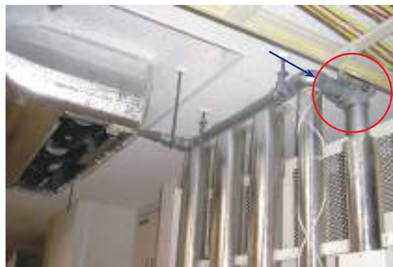
空調ドレン配管(改修用)施工写真 使用サイズ 50(主管)×40A(枝管)
