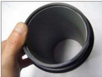
パッキン装着後の防食材密着作業
