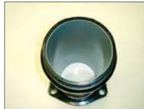
パッキン装着完了
